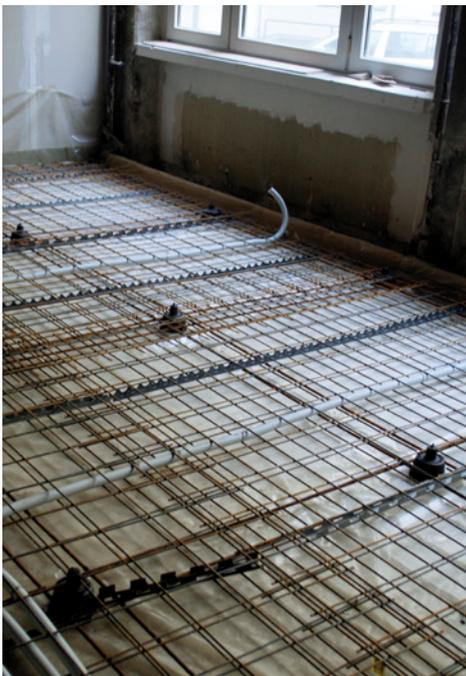
Betonplattenarmierung mit Neoprenlager
