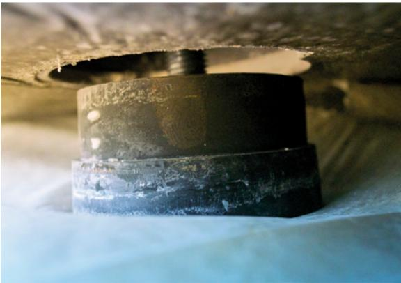
Neoprenlager für Betonplatte
