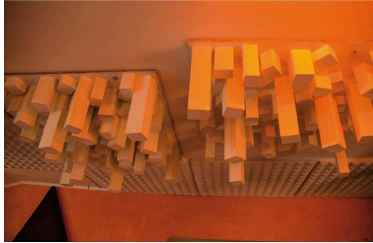
Selbst gebaute Skyline-Diffusoren mit erweiterter Bandbreite
