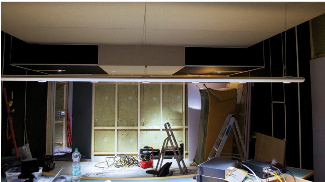
Blick in den rückwärtigen Bereich des Regieraums. Man erkennt die mit Mineralwolle belegten Absorptionsflächen, die in Kombination mit der biegeweichen Rückfront und dem dahinter liegenden Maschinenraum einen Breitbandabsorber bis hin zu tiefsten Frequenzen bilden
