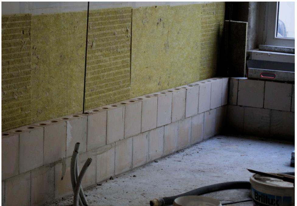
Massive innere Schale auf der Betonplatte
